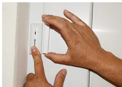
3. Vissez le support de l'émetteur sur le dormant\* de votre ouverture au niveau des emplacements de fixation et le support de l'aimant sur l'ouvrant\* de votre porte/fenêtre. L'écart entre les 2 parties doit être inférieur à 0,5cm.
