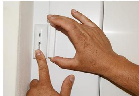
4. Clipsez fermement les capots sur les supports vissés. Le bouton d'autoprotection à l'intérieur de l'émetteur doit être correctement enclenché.
